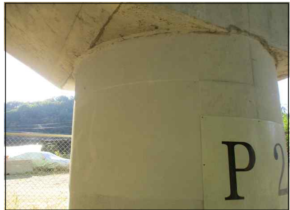
교각 기둥 보수현황(P2)
