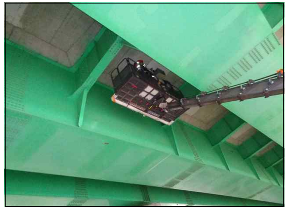
작업차량을 이용한 외관조사
