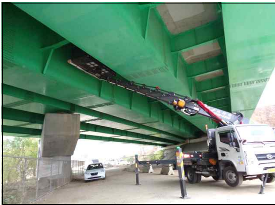
작업차량을 이용한 외관조사
