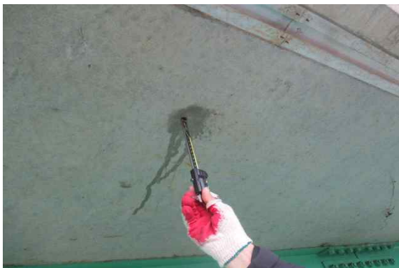
탄산화 깊이 측정현황
